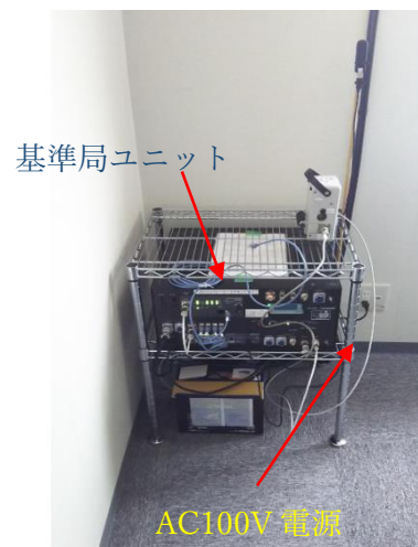
図-9 基準局ユニット設置状況
