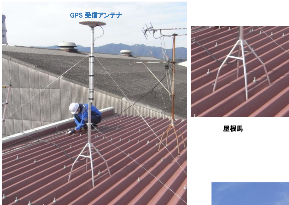
図-6 GPS 受信アンテナ設置状況
